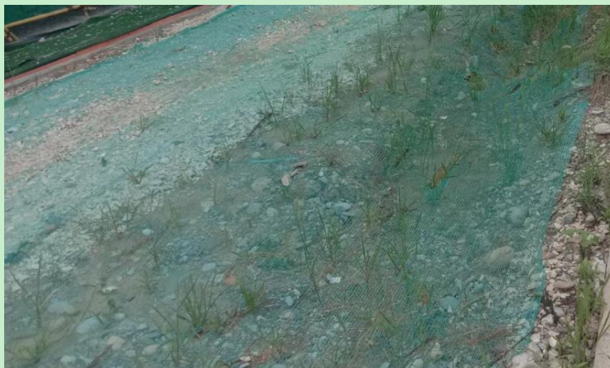
图 5.4.2-2 已实施密目网苫盖影像
