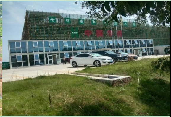
施工生产生活区现状影像
