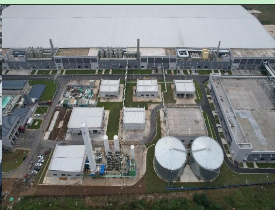
室外水罐及附属罐区现状影像
