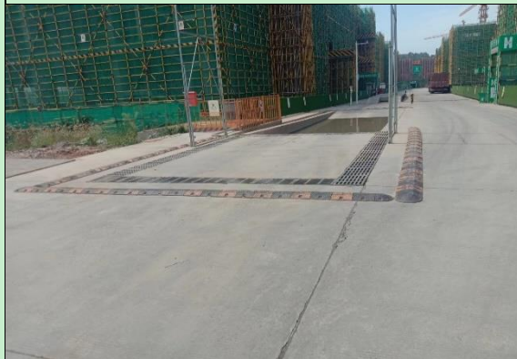
已建洗车设施现状影像
