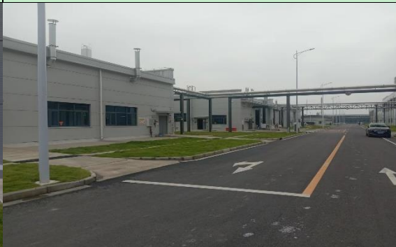
项目区道路硬化及草籽绿化现状
