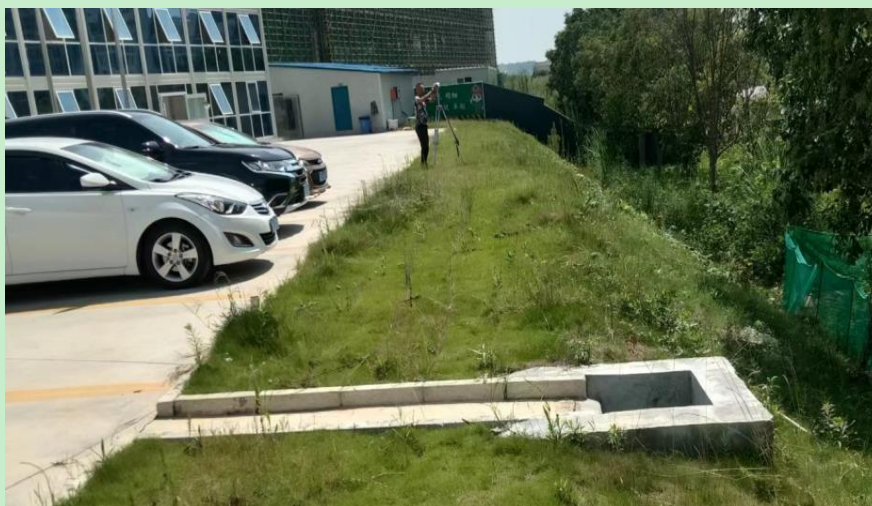
图 5.4.3-2 已实施排水沟及沉沙池影像
