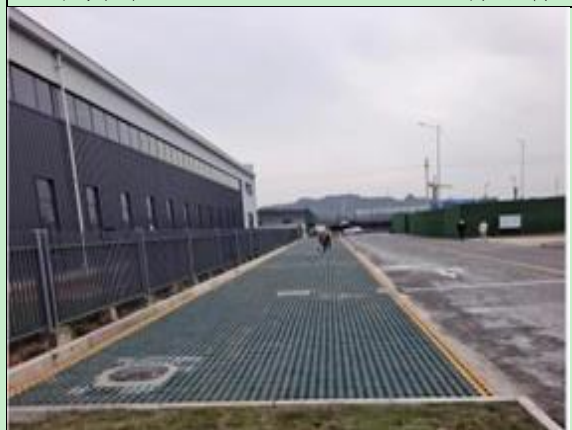
项目区透水铺装车位现状影像
