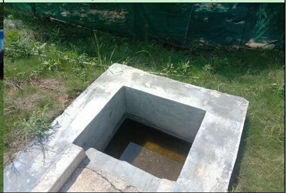
已建沉沙池现状影像
