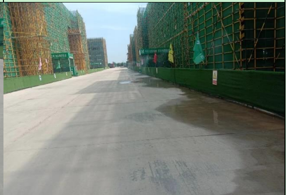
已建场内道路现状影像
