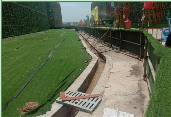
已建临时排水沟现状影像
