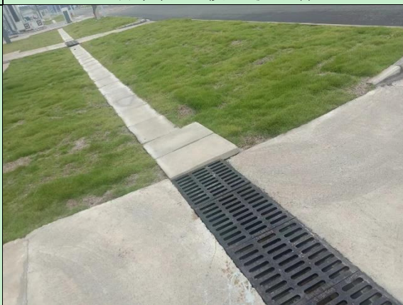
项目区排水沟及草籽绿化现状
