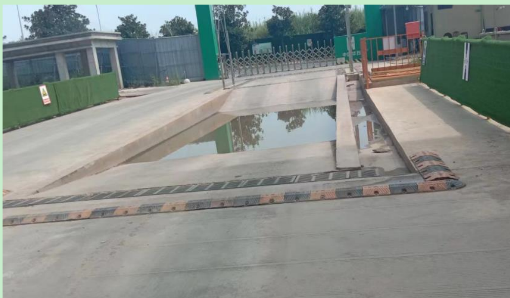
图 5.4.3-1 已实施洗车池影像
