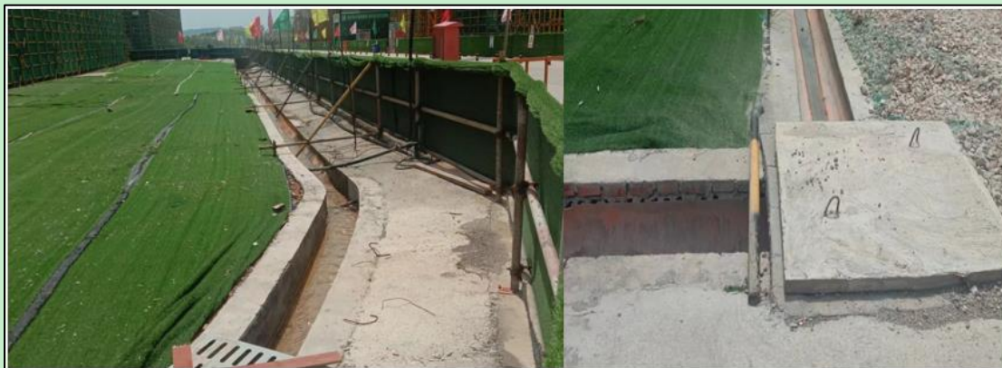
图 5.4.2-1 已实施临时排水沟、沉沙池影像
