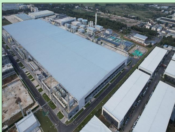
4#电池车间现状影像
