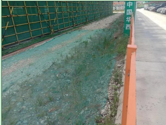
已实施密目网苫盖影像
