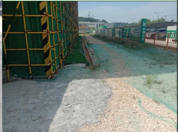
已实施密目网苫盖影像
