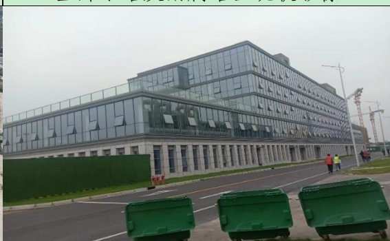
2#行政办公楼现状影像
